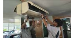
การทำทำความสะอาดเครื่องปรับอากาศ
