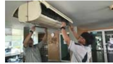
การทำทำความสะอาดเครื่องปรับอากาศ
